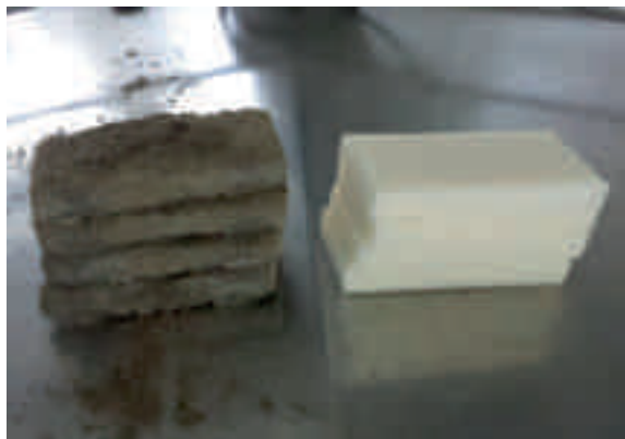
Filtri della valvola regolatrice del vuoto. A sinistra sporchi (1 anno di vita) a destra nuovi.
