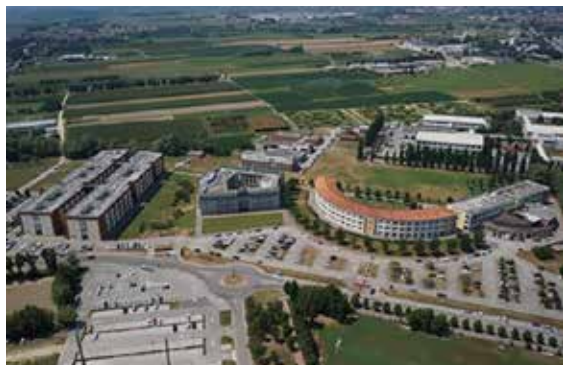
41. Veduta aerea del Campus di Agripolis, Legnaro (Padova).
