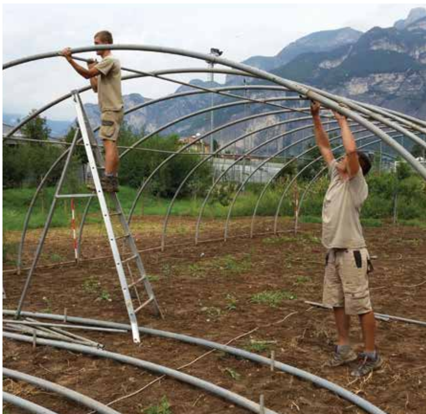
Realizzazione della serra - tunnel .....
