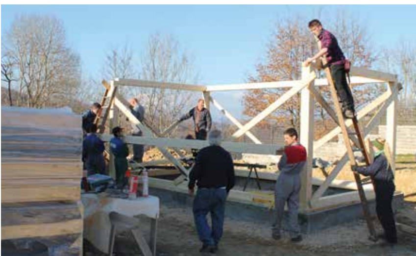
Amatrice: il montaggio del manufatto costruito a San Michele
