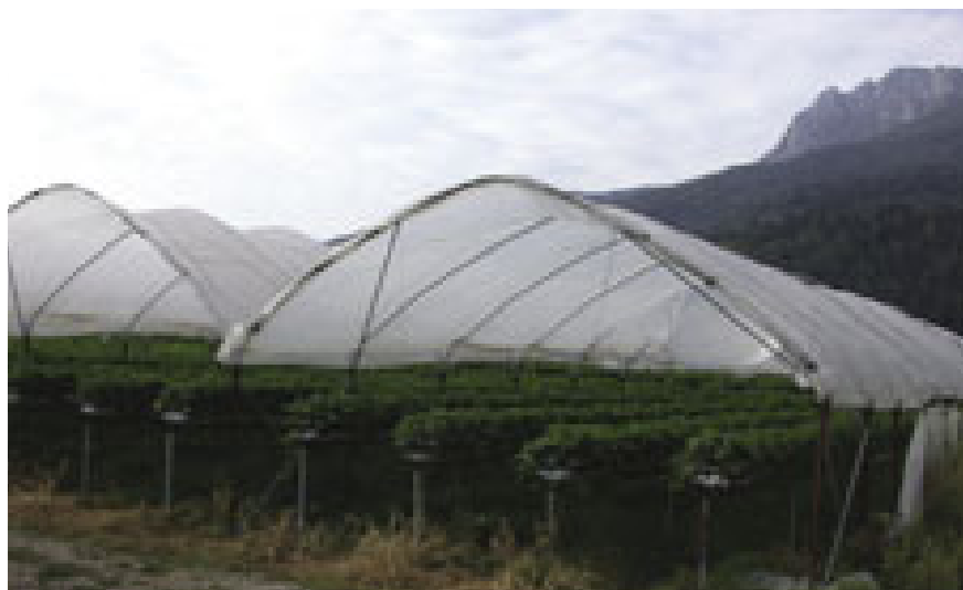
Fig. 52 Coltivazione fuori suolo, sotto tunnel (Trentino)
