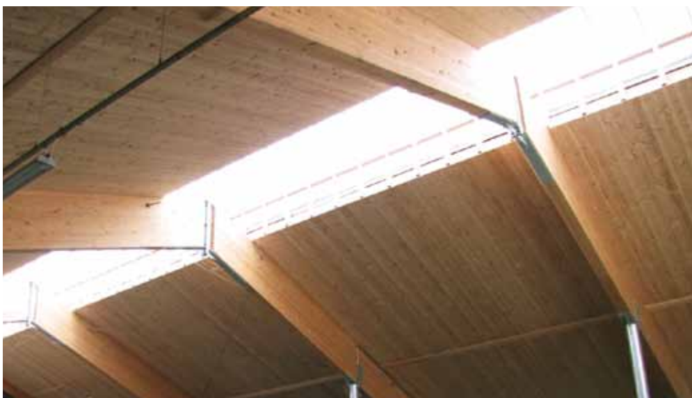
Fig. 18 - Cupolino di aerazione
