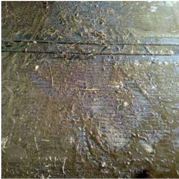
Fig. 4 - Pavimento in calcestruzzo rigato
