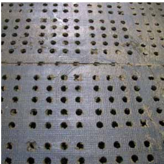
Fig. 6 - Pavimentazione in gomma con fori
