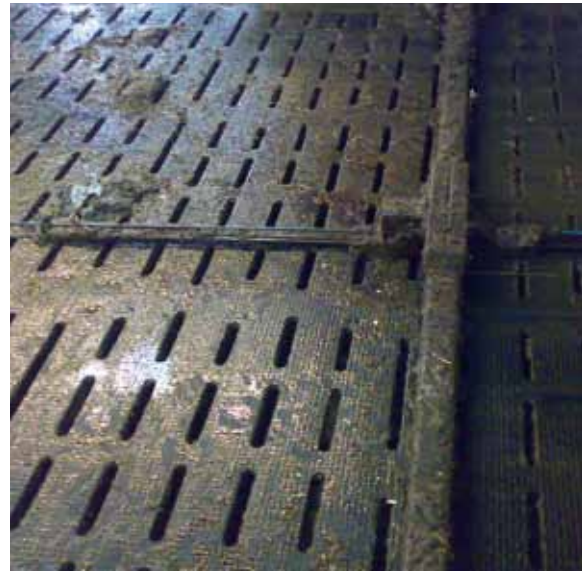
Fig. 5 - Pavimentazione in gomma con fessure longitudinali
