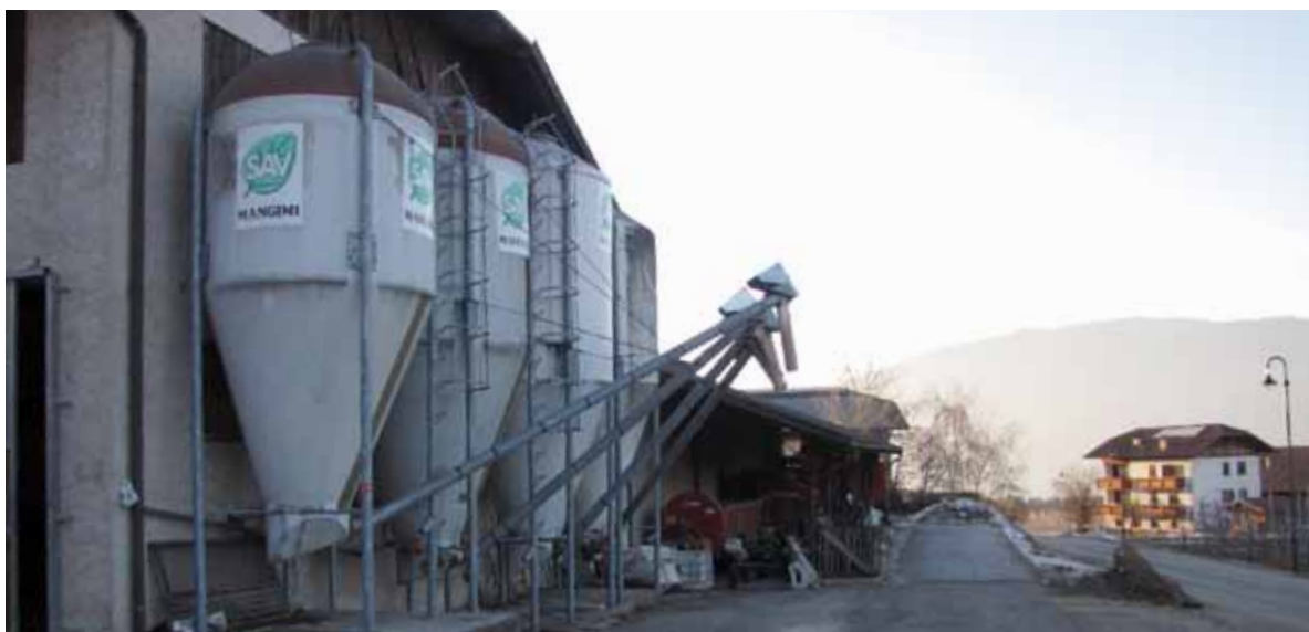
Fig. 10 - Silos in vetroresina
