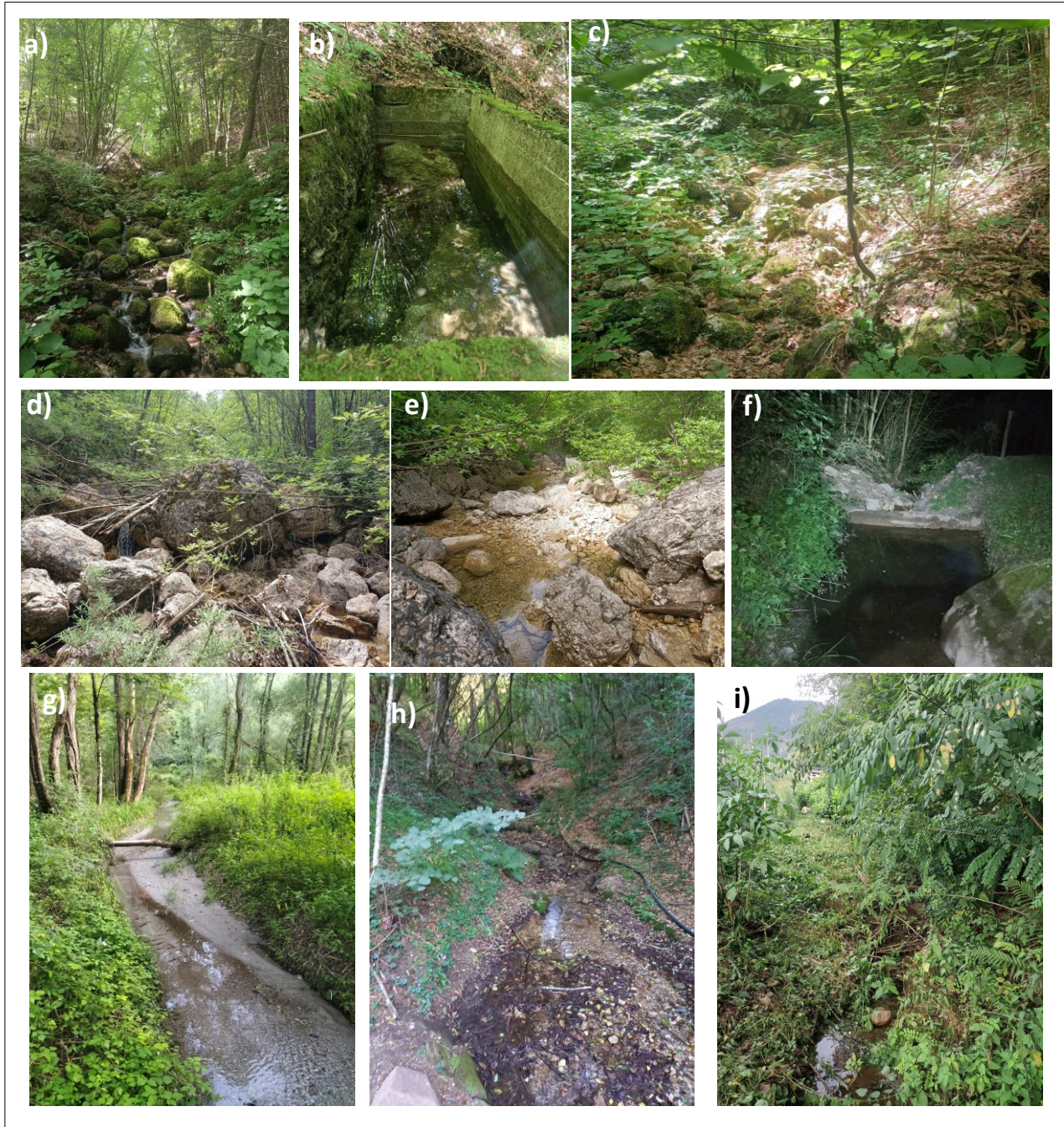
Figura 13. Esempi di alterazione dell'habitat. Rio Pezzati, 20 giugno 2023 (bacino Fiume Leno): a) tratto a monte vasca di captazione; b) vasca di captazione; c) tratto in secca a valle della vasca. Esempi di carenza idrica: d, e) Rio Gerlano, 20 giugno 2023 (bacino Fiume Leno); f) Roggia Gardolo 11 settembre 2023, vasca artificiale nel tratto terminale del transetto; g) Rio Folon di Zuclò, 8 agosto 2023; h) Rio Vallata, 11 settembre 2023. Esempio di alterazione dell'habitat: i) fosso Pergine, 11 settembre 2023.
