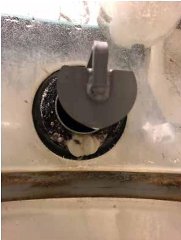
**Importante deposito di materiale organico in vaso terminale di in impianto di mungitura legato a mancanza di turbolenza e temperatura dell'acqua**
