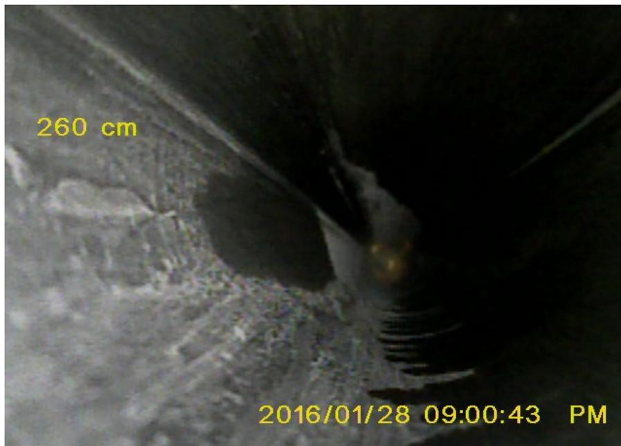
**Lattodotto: valutazione tubazione mediante sonda endoscopica. Depositi di materiale organico**
