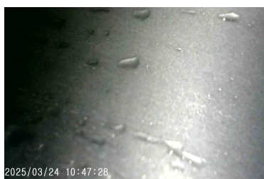
Ispezione del lattodotto post intervento tramite sonda endoscopio
