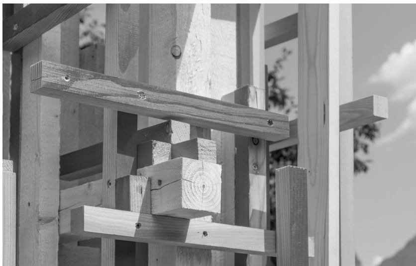
Fig. 02-03-04. Spazi rigenerati per comunità che si ritrovano. Un nuovo giardino per l'asilo di Sagron, Sagron-Mis (TN) (© Camposaz, 2020)
